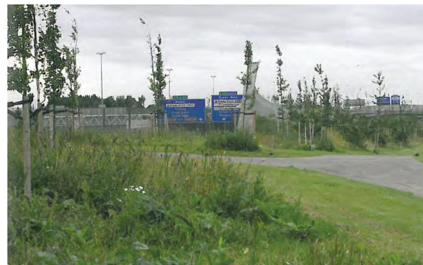
Fig. 5: De stadsviaducten boven de A 16 bij Breda tijdens en na de bouw
